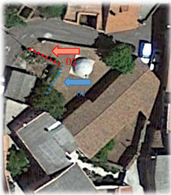
Vista area muro – foto 1
