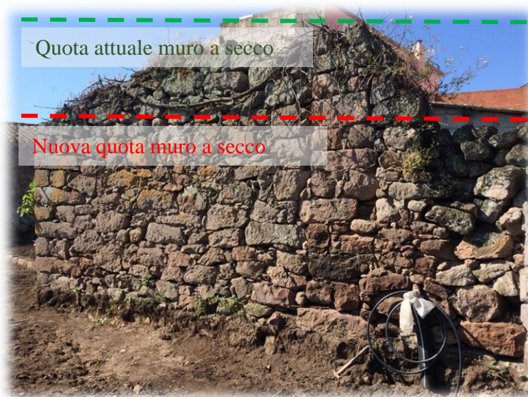
Stato di fatto tratto 02 – foto 3
